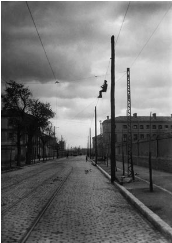
Alfonso 1927 , Colocación de anillos, Zaragoza.
